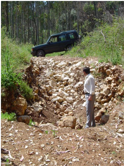
Fot. 5 e 6 – Pormenores das “crateras” construídas pela erosão, no Vale Fernando.
